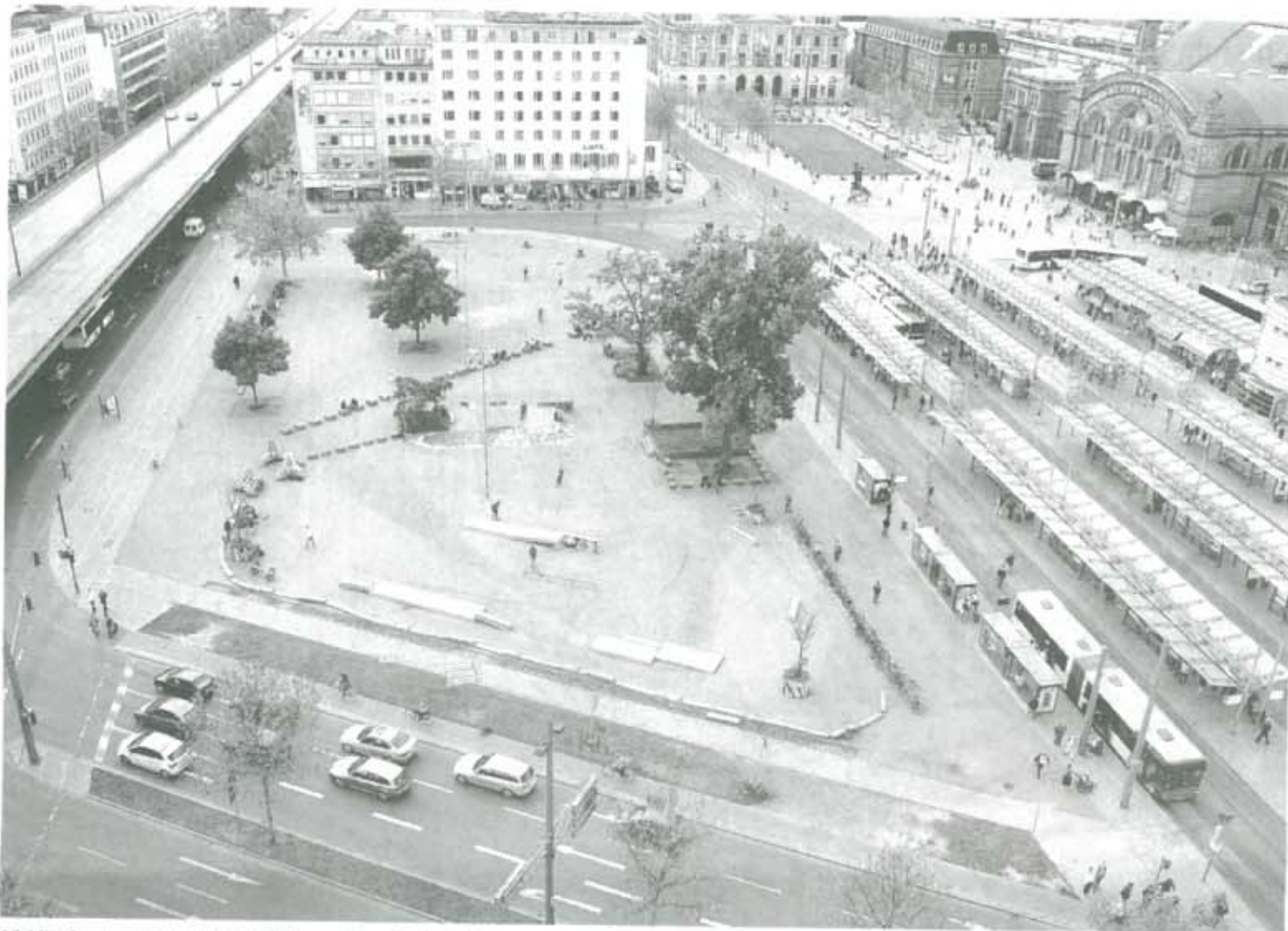
20000 Quadratmeter ist die Fläche auf dem Bahnhofsplatz groß. Derzeit verhandelt die Stadt mit einem möglichen Investor. Wer es ist, darüber schweigt sich die Behörde aus. Ende des Sommers soll Klarheit herrschen.
